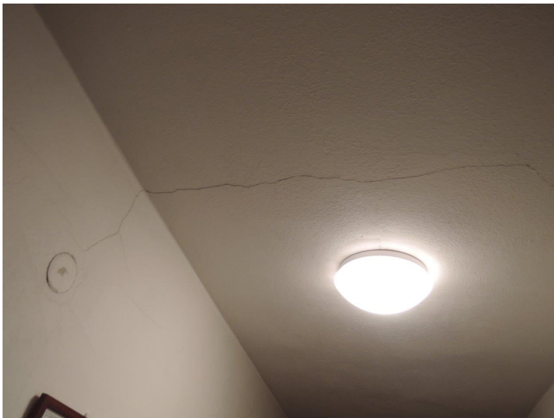
Foto č.27 - chodba v patře – praskliny na stropě a stěně
